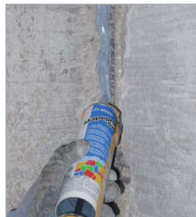
Fig. 8.1b - Estrusione di MAPEPROOF SWELL
