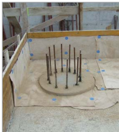
Fig. 7.20 - MAPEPROOF sagomato intorno alla testa del palo
