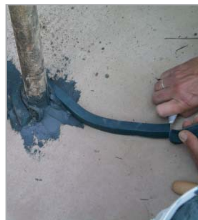
Fig. 7.60c - Posa di IDROSTOP B25
