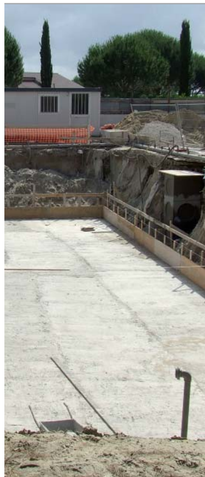
Fig. 4.1 - Scavo di sbancamento non confinato
