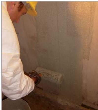
Fig. 8.8e - Applicazione di MAPELASTIC FOUNDATION
