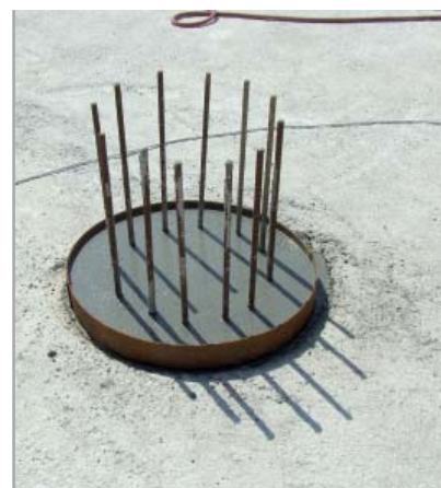
Fig. 7.17 - Testa del palo ricostruita con MAPEGROUT COLABILE
