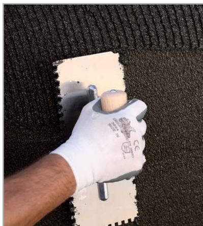
Fig. 7.53 - Applicazione di PLASTIMUL 2K PLUS
