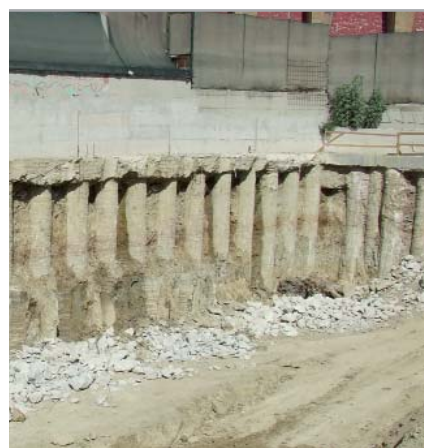
Fig. 4.3 - Scavo di sbancamento confinato mediante pali trivellati
