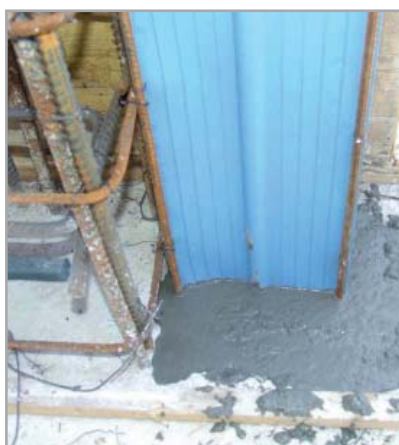
Fig. 7.56e - Ripristino della fondazione con MAPEGROUT COLABILE
