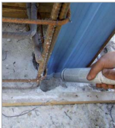
Fig. 7.56d - Sigillatura con MAPEPROOF SWELL
