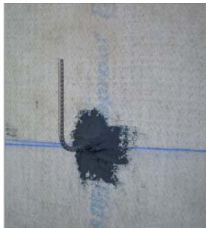
Fig. 7.69 - Stuccatura dei connettori metallici con MAPEPROOF MASTIC
