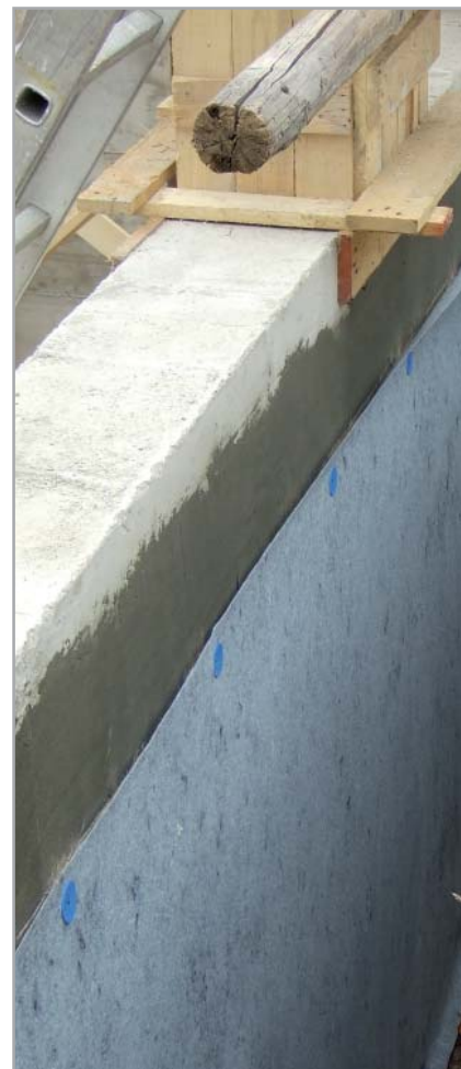
Fig. 7.49 - Protezione dell'impermeabilizzazione nelle fasi di reinterro, mediante la stesura di tessuto non tessuto da 250 g/m² a filo continuo
