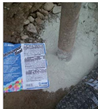
Fig. 7.60a - Fasi della sigillatura di una tubazione passante la platea: applicazione di MAPEPROOF SEAL attorno la tubazione passante
