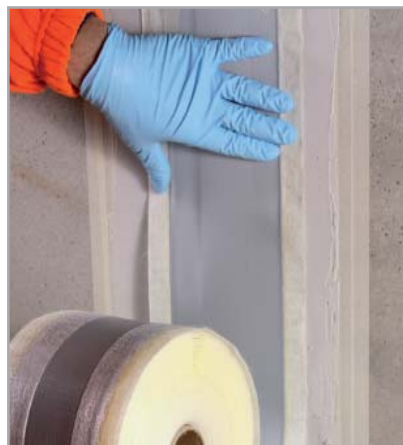
Fig. 7.48c - Posizionamento di MAPEBAND TPE
