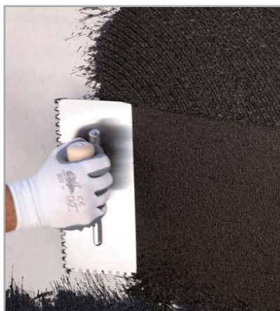
Fig. 7.54 - Applicazione di PLASTIMUL 2K SUPER
