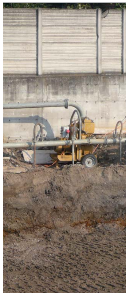
Fig. 3.7 - Pompa autoadescante utilizzata nel sistema wellpoint
