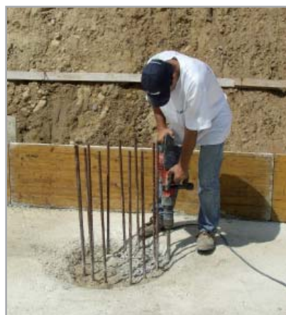
Fig. 7.15 - Scapitozzatura della testa del palo
