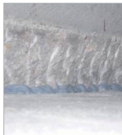
Fig. 8.1c - Ripresa di getto sigillata con MAPEPROOF SWELL
