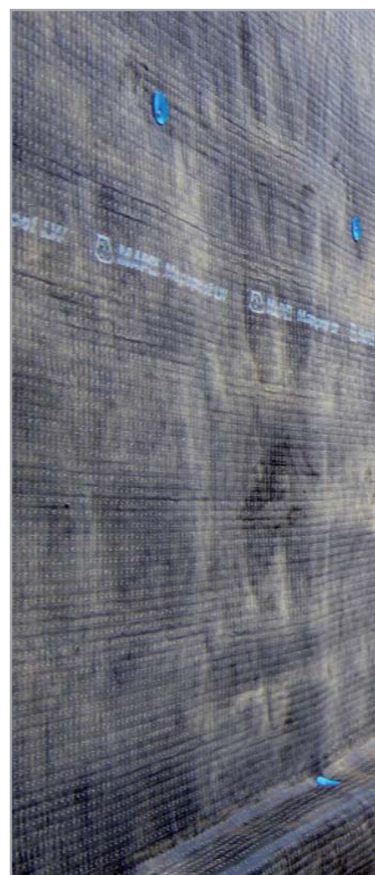
Fig. 5.3 - Esempio di applicazione di MAPEPROOF in post-getto
