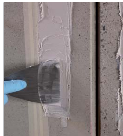
Fig. 7.48b - Stesura a spatola di ADESILEX PG4
