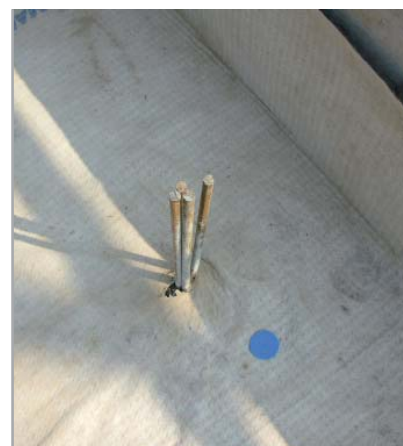
Fig. 7.24 - MAPEPROOF attraversato dalle armature del palo
