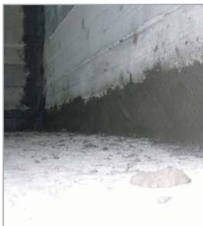
Fig. 8.1e - Riprese di getto sigillate e ripristinate
