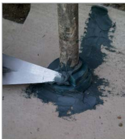
Fig. 7.60e - Ulteriore stuccatura mediante MAPEPROOF MASTIC
