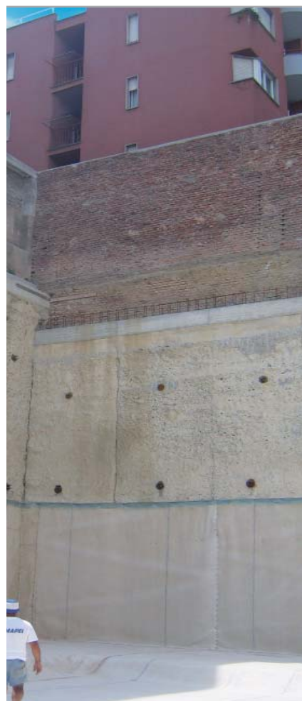
Fig. 4.2 - Scavo di sbancamento confinato mediante diaframmi
