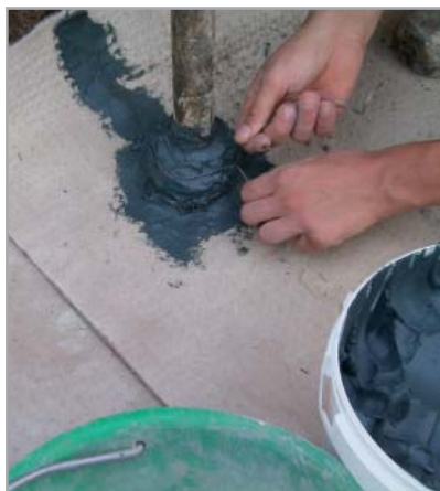
Fig. 7.60d - Fissaggio di IDROSTOP B25 mediante filo metallico
