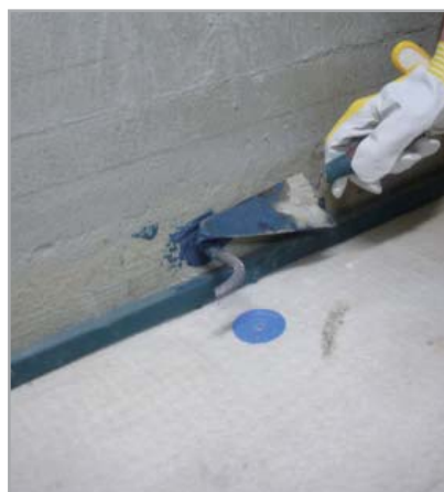
Fig. 8.6f - Stuccatura dei connettori metallici mediante MAPEPROOF MASTIC
