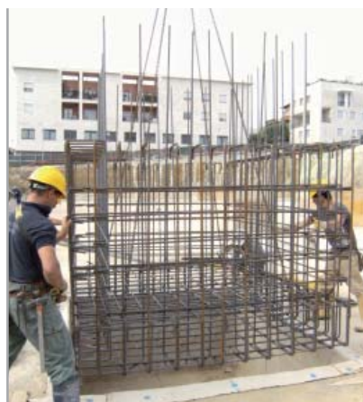
Fig. 7.5c - Posizionamento delle armature
